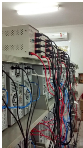
Figura 3: Visão dos corredores quente, com detalhes das estruturas de distribuição elétrica e de comunicação de redes.
