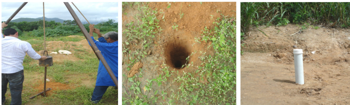
Figura 2 - Processo de perfuração dos poços e preservação
