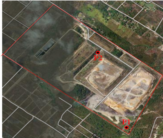
Figura 1- Demarcação do aterro e localização dos poços.
